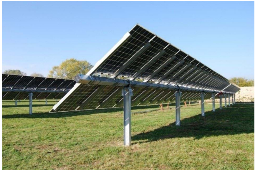
Figur 7. Foto af række med Tracker opstilling
