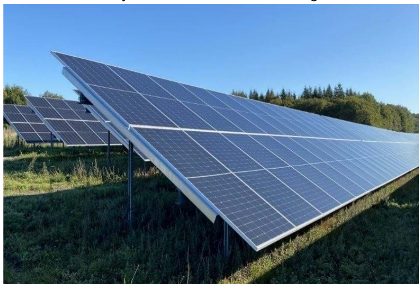
Figur 4: Eksempel på Fixed-tilt S opsætning.
