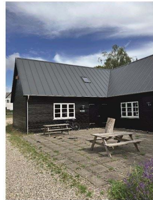
Nyere undervisningsbygning fra 2016
