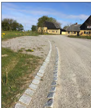
Eksempel fra lokalplanområdet på åben rende til afledning af regnvand
