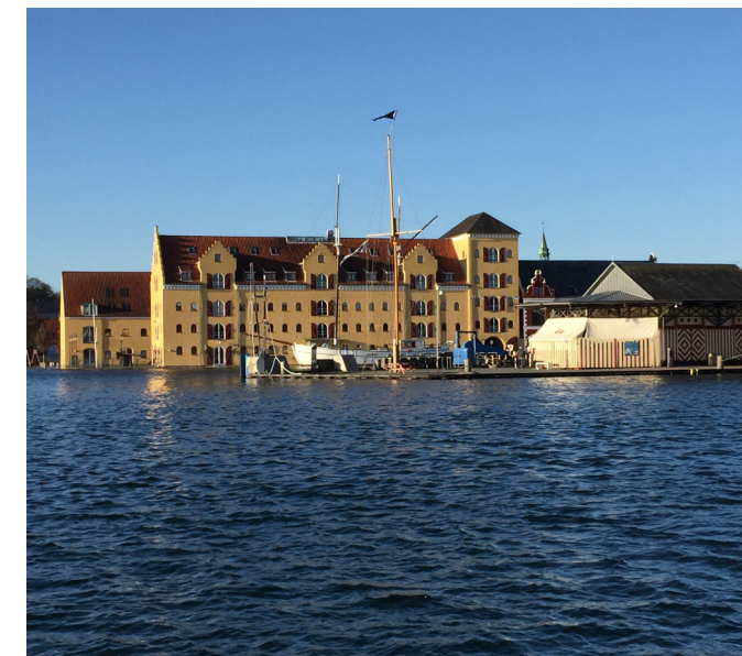
Forhøjet vandstand i Svendborg Havn, Honnørkajen 2019
