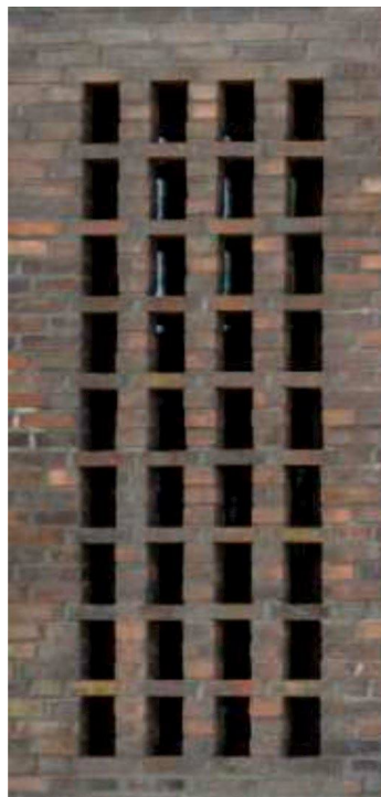
Figur 10 - Referencefotos der viser eksempel på fletmurværk, der fungerer som afkast for indvendigt ventilationsanlæg
