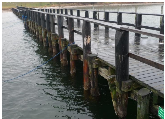
Stenbelægning for enden af broen (tv). Den gamle trækonstruktion kræver løbende fornyelse (th).
